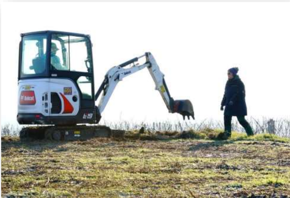
schwerer Eingriff, entfernen einer Zisterne
