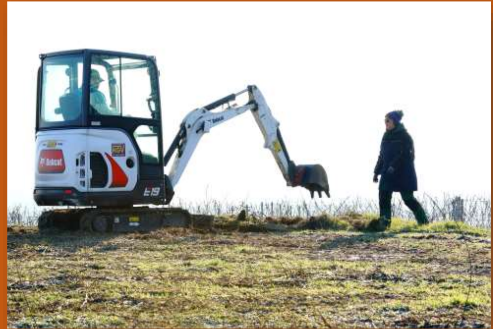
schwerer Eingriff, entfernen einer Zisterne
