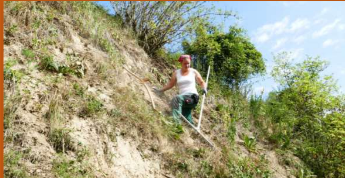
Mahd einer Böschung mit Schnittgutabtragung
